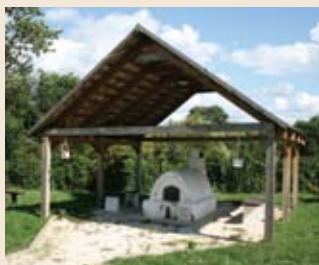
Újonnan épített palóc kemence (Kutasó)
